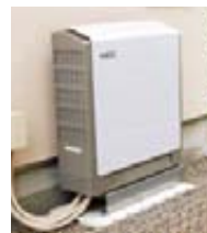
NEC製蓄電池
