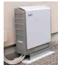
NEC製蓄電池
